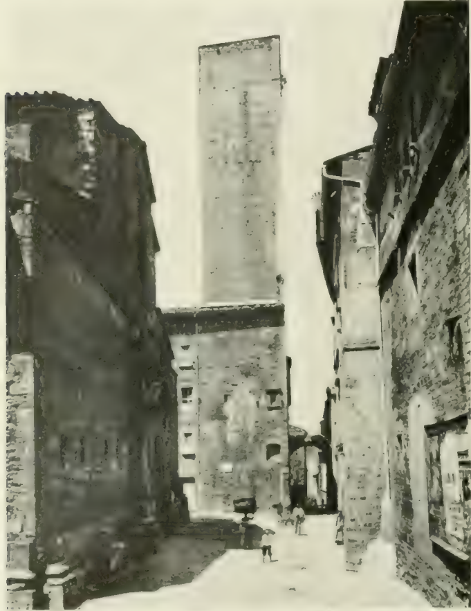
FIG. 1. Torre dei Sciri.
